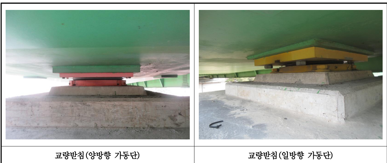
【사진 1.3.13】 교량받침 전경
