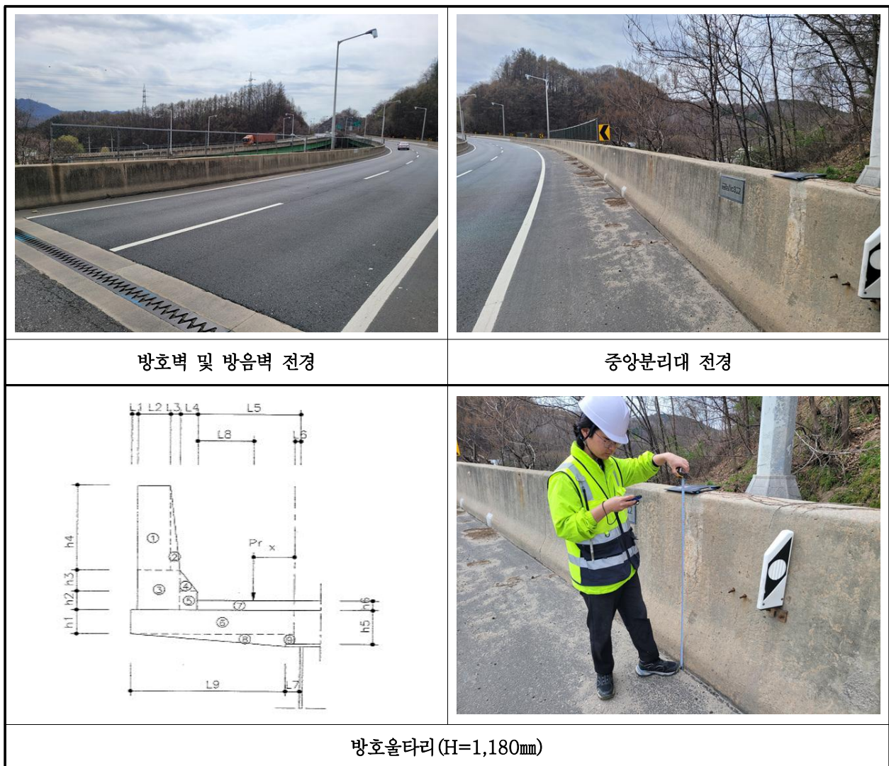
【사진 1.3.21】 난간 및 연석 전경
