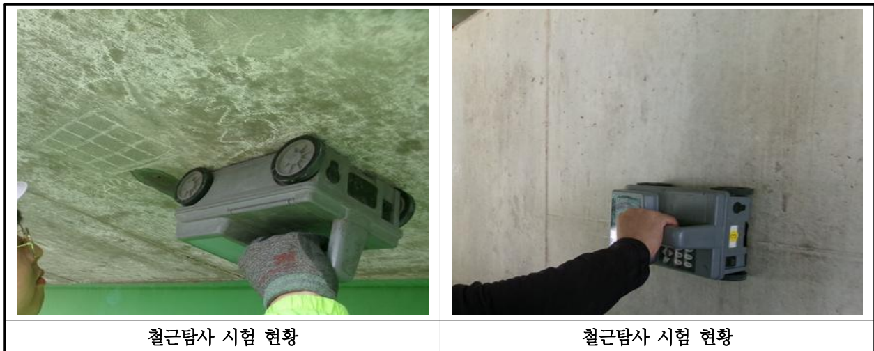
【사진 1.4.2】 철근탐사 시험
