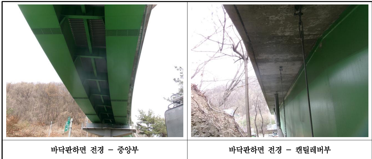
【사진 1.3.2】 바닥판하면 전경
